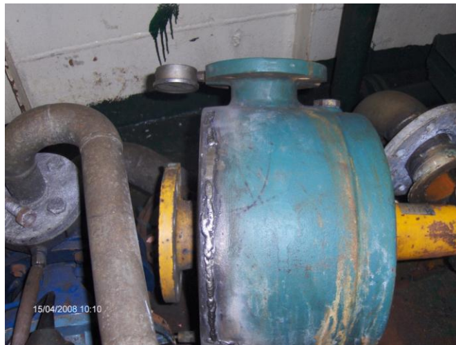
Brannpumpe om bord i M/S Solskjær sveist med Magna 777 AC-DC
